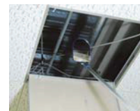
天井裏の点検に
