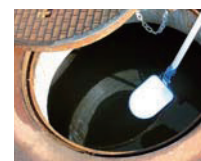
下水管の点検に
