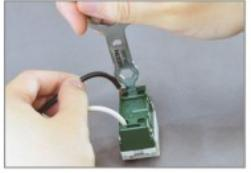
器具のはずし穴に差し込み、電線を取り外すことができます。
