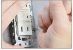
埋込連用取付枠へ器具を取り付ける/取り外す。
